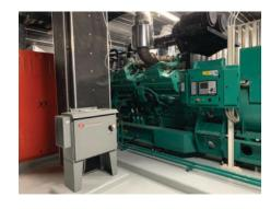
สิ่งแรกที่จะกล่าวถึงคือเครื่องกำเนิดไฟฟ้า หลายท่านอาจคิดว่าเครื่องกำเนิดไฟฟ้านั้น ไม่สำคัญ เพราะเรามีไฟฟ้าจากการไฟฟ้า หรือ public utility แต่ในหลักเกณฑ์ของ Uptime นั้น ไม่ได้นับแหล่งจ่ายไฟฟ้าจาก การไฟฟ้า จะนับจากเครื่องกำเนิดไฟฟ้า เท่านั้น และด้วยการออกแบบ TIER III ทำให้ ต้องมีการสำรองเครื่องกำเนิดไฟฟ้าอีก 1 ชุด และในการทดสอบ TCCF นั้นต้องใช้ ไฟฟ้าจาก Generator เท่านั้นอีกด้วย
